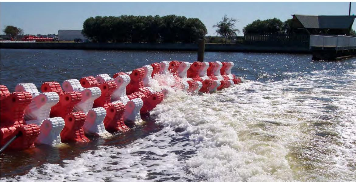
Sistema atenuador del oleaje en operación. Fotografía: Wave Dispersion Technologies CC-BY-SA-2.0
