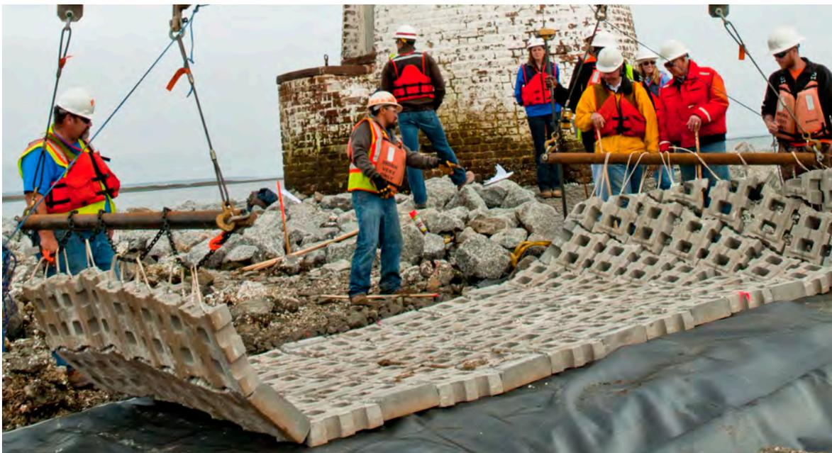
Figura 21. Ejemplo de bloques interconectados. Fotografía: US Army Corps of Engineers Savannah District CC-BY-SA-2.0
