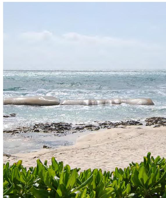
Bolsas de geotextil utilizadas para la regeneración de una playa. Fotografía: Axis Ingeniería
