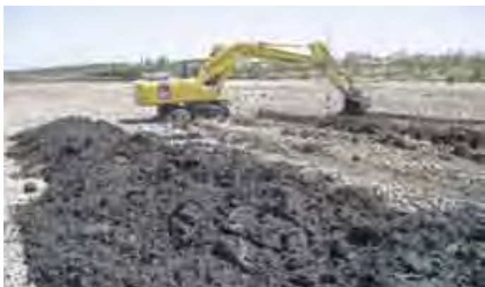
Retirada de lodos del Laguneto
