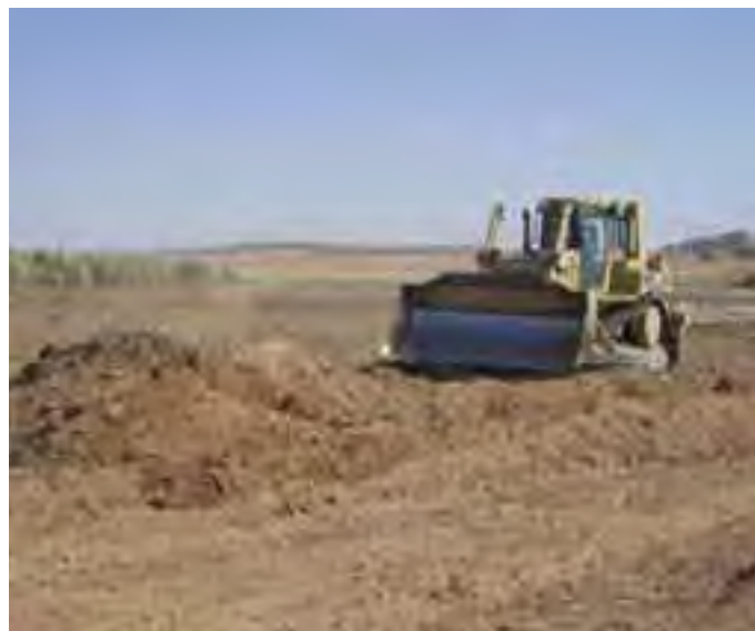
Retirada de sedimentos en la laguna de Cantarranas, Fuente de Piedra
