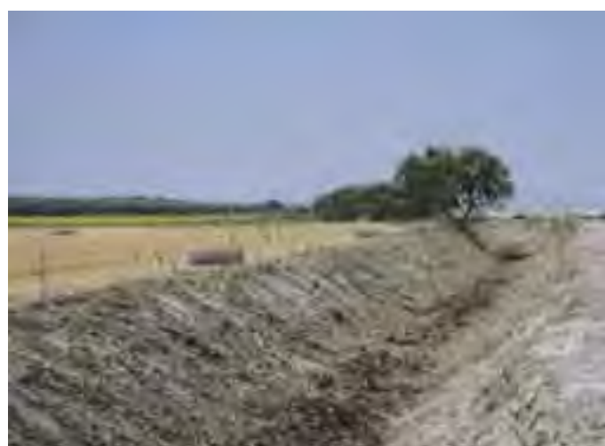
Acequia tras las labores de limpieza de matorrales
