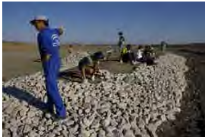
Protección de una isla contra la erosión con piedras en el Laguneto
