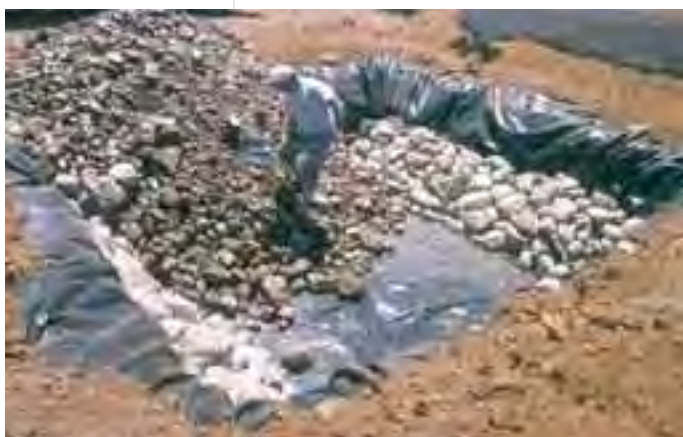
Construcción de humedal artificial
