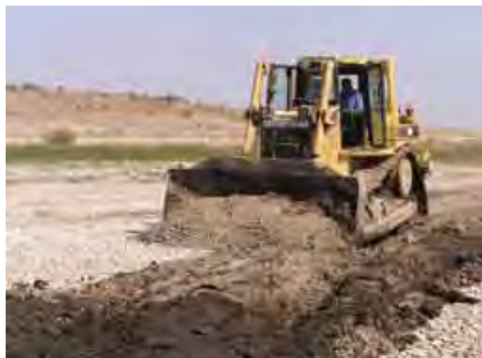
Acopio de lodos del fondo del Laguneto
