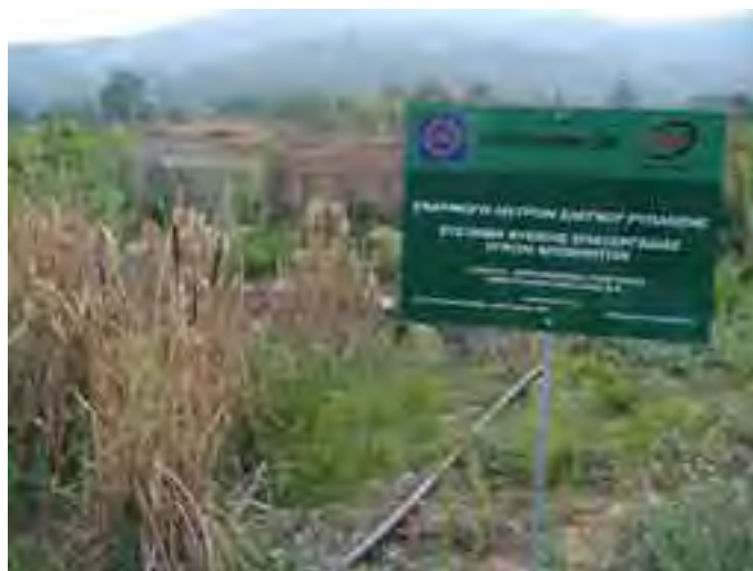
Humedal de tratamiento de aguas residuales
