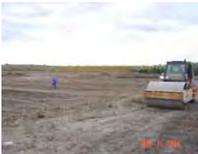
Compactación del terreno
