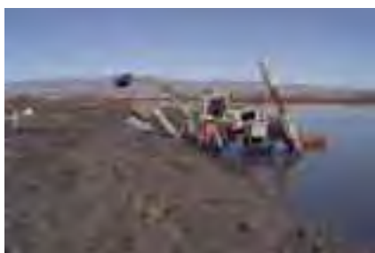
Restauración de dique salinero
