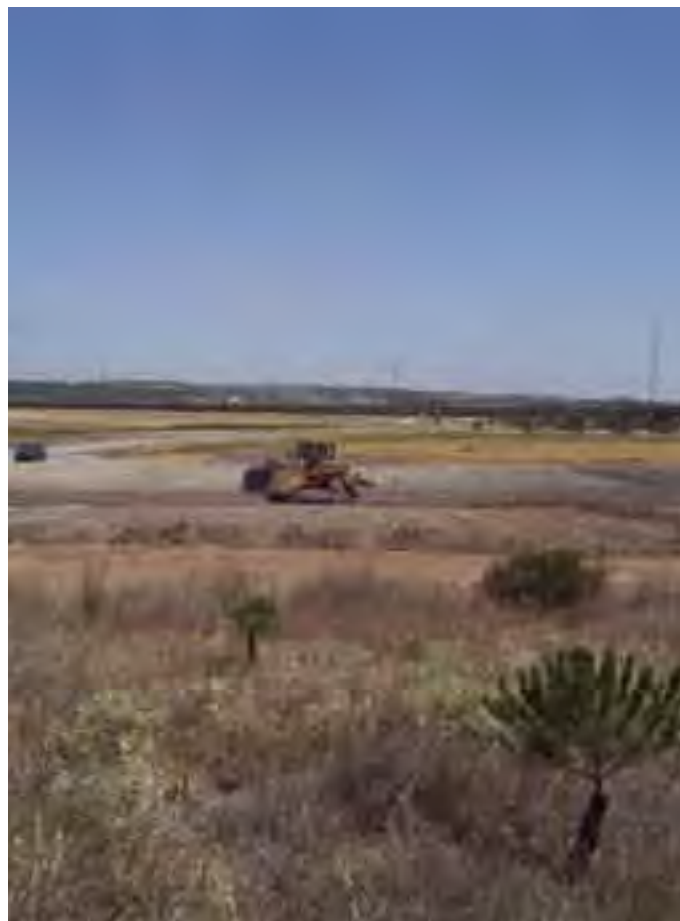
Máquina retirando sedimentos de la Laguna de los Juncares
