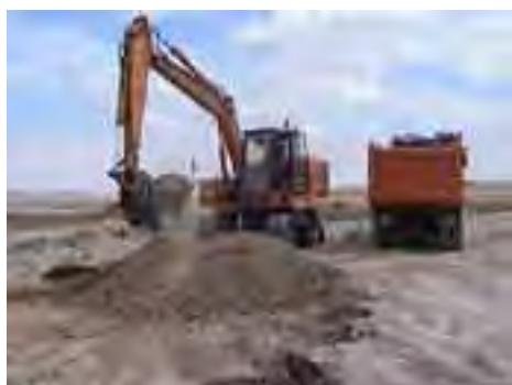
Obras de restauración de laguna desecada
