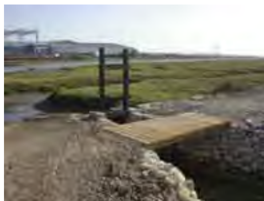
Compuerta restaurada en la salina del Consulado
