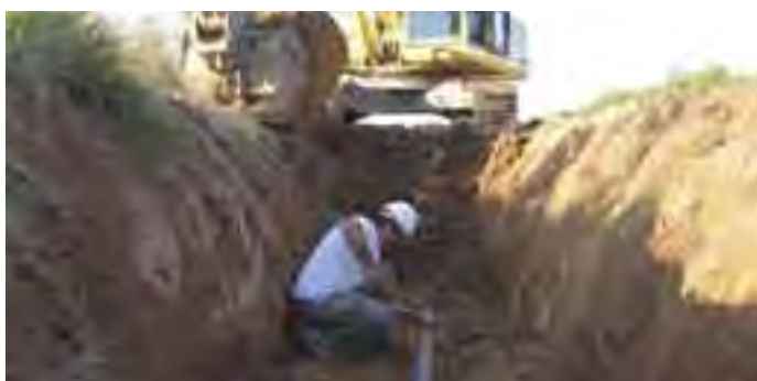
Apertura de nuevos canales para los aportes de la EDAR II de Fuente de Piedra
