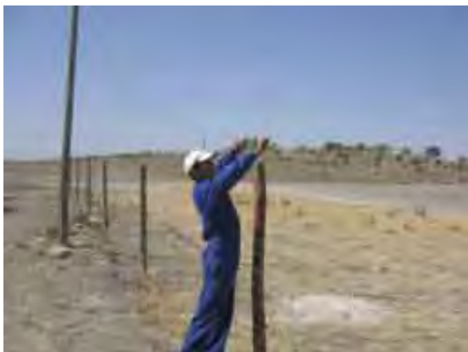
Labores de colocación del nuevo cerramiento
