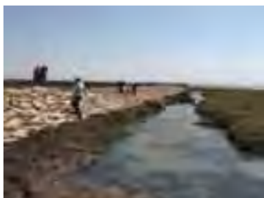
Colocación manual de esollera en la salina del Consulado
