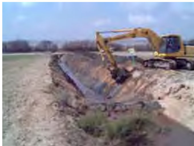
Limpieza del canal del Laguneto a la Laguna
