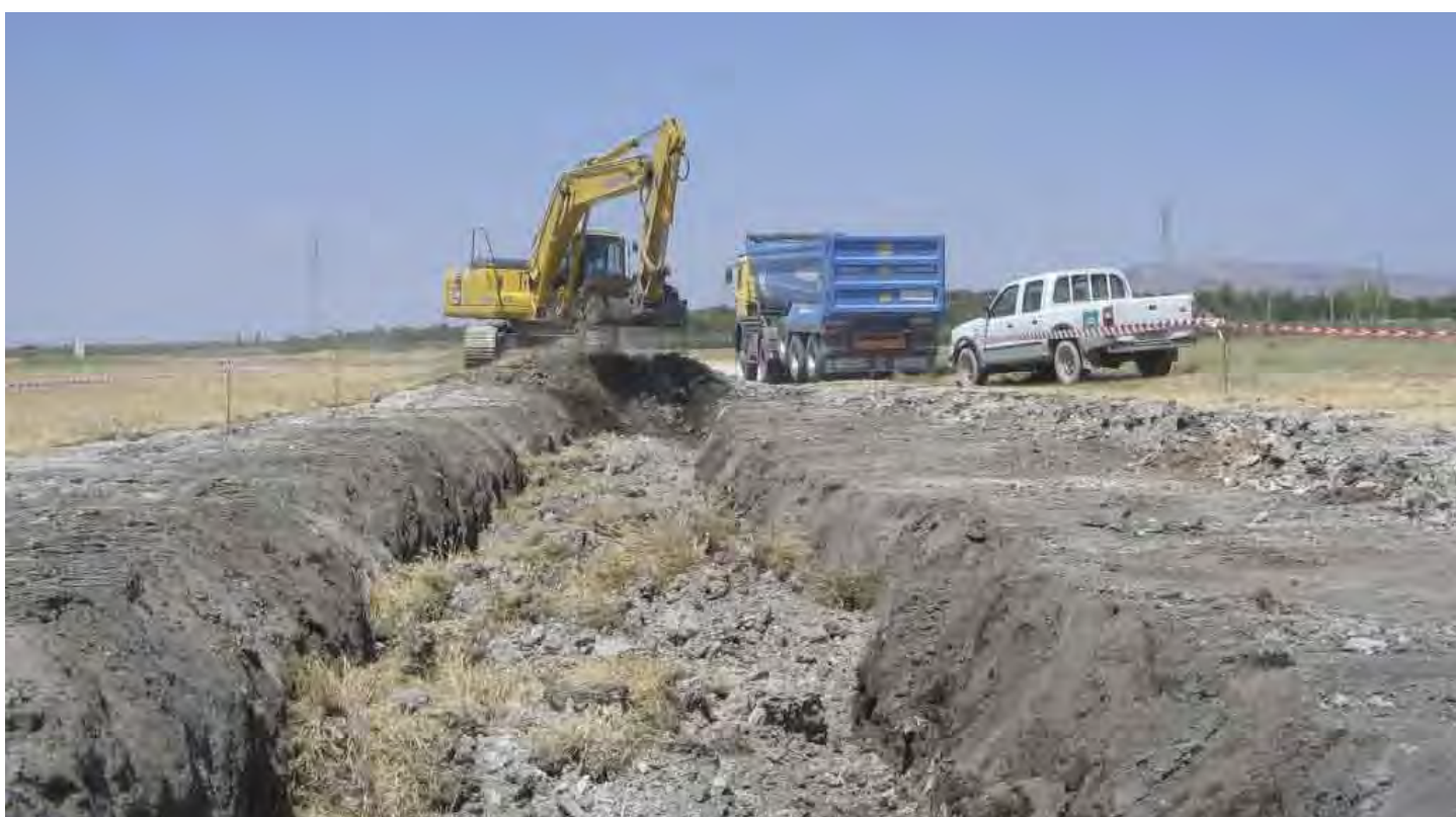
Restauración de un antiguo vertedero de residuos sólidos urbanos
