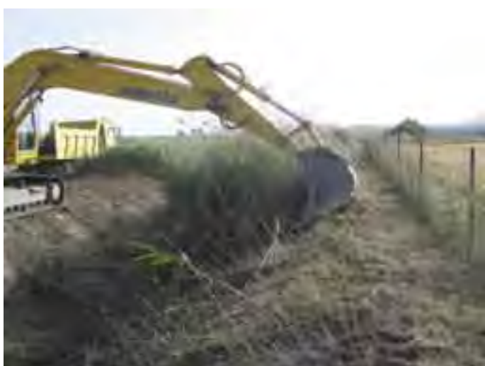
Eliminación de matorral en acequia
